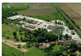
WESER Aquitaine/WA Lot-et-Garonne (47) Surface totale de 4 ha Surface couverte de 2 500 m 2
