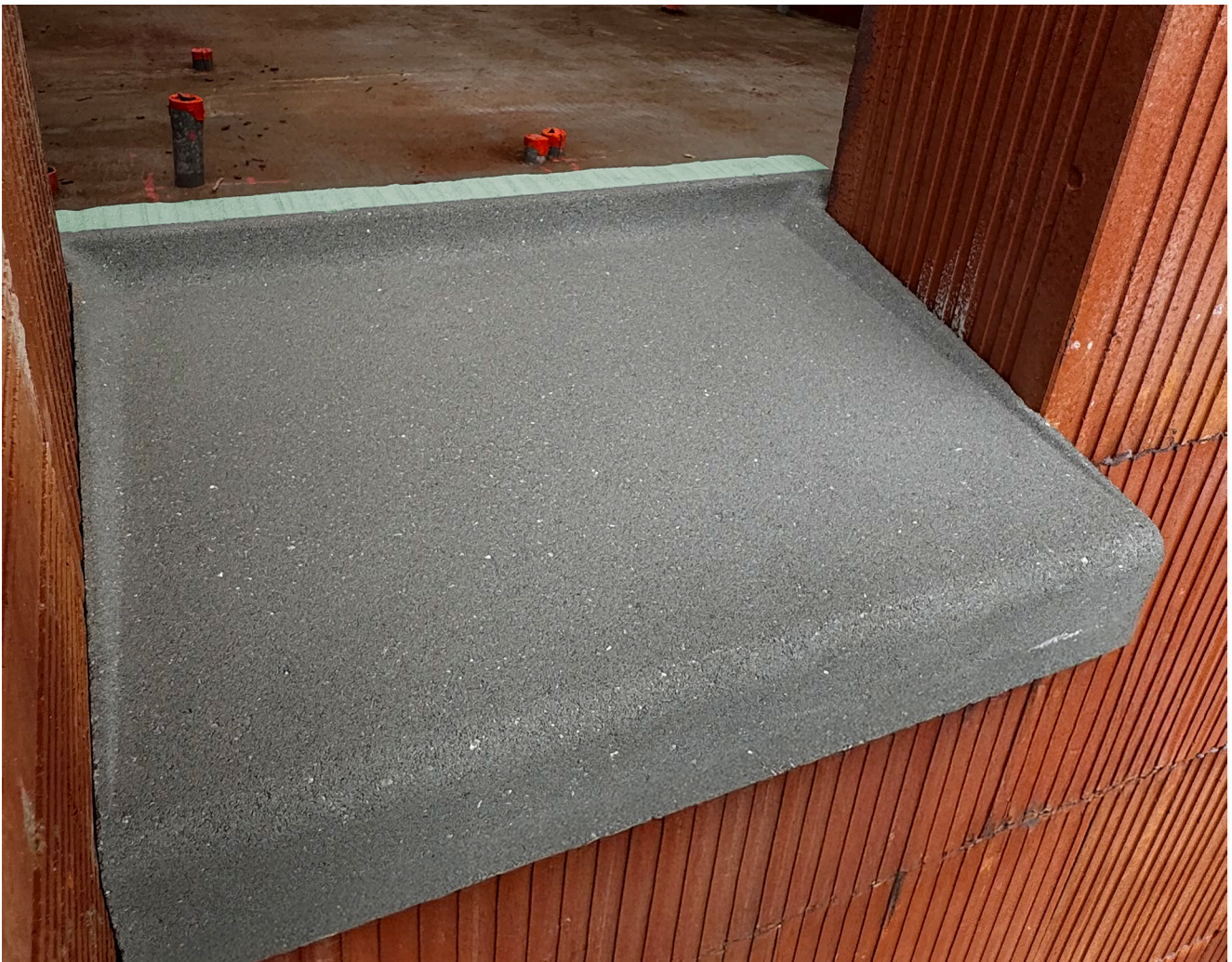
Installation par emboîtement
