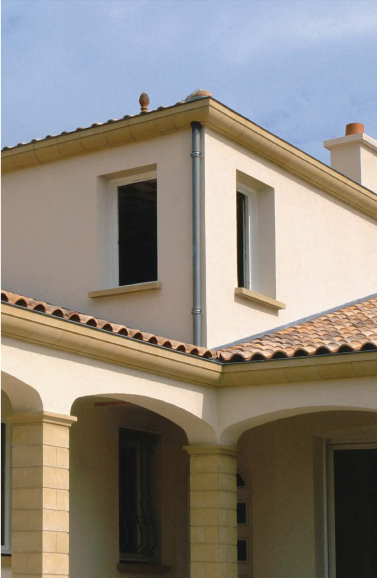
Corniches Cache-Gouttière – Ton Pierre
