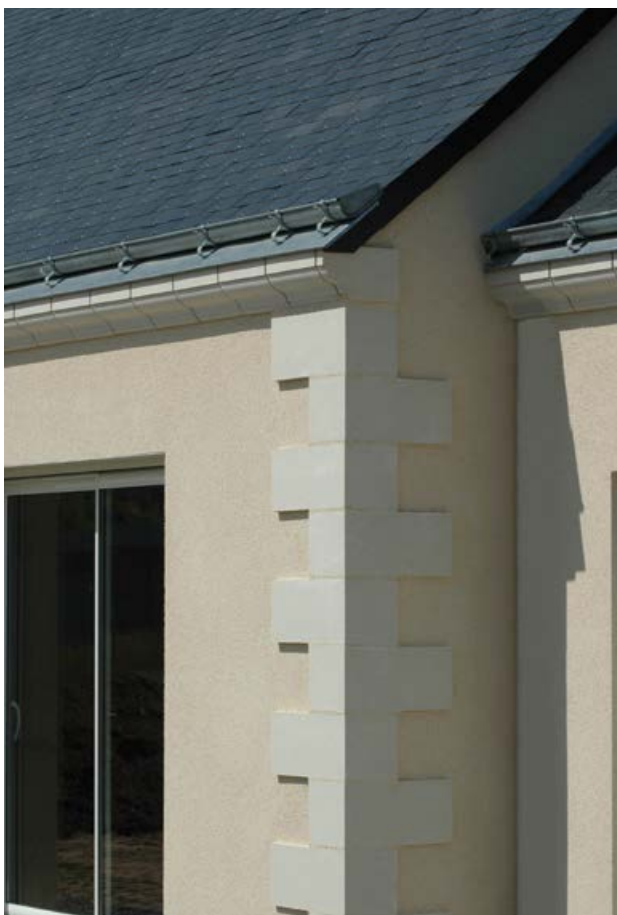
Chaîne d'angle pose harpée – Blanc Cassé
