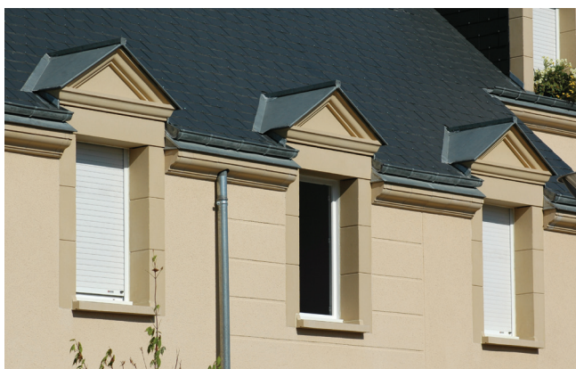
Lucarnes à fronton (pose en gerbière)
