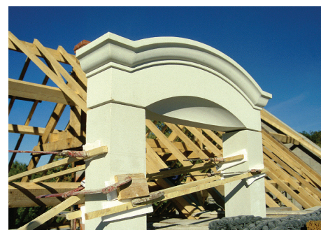
Mise en œuvre lucarne chapeau de gendarme
