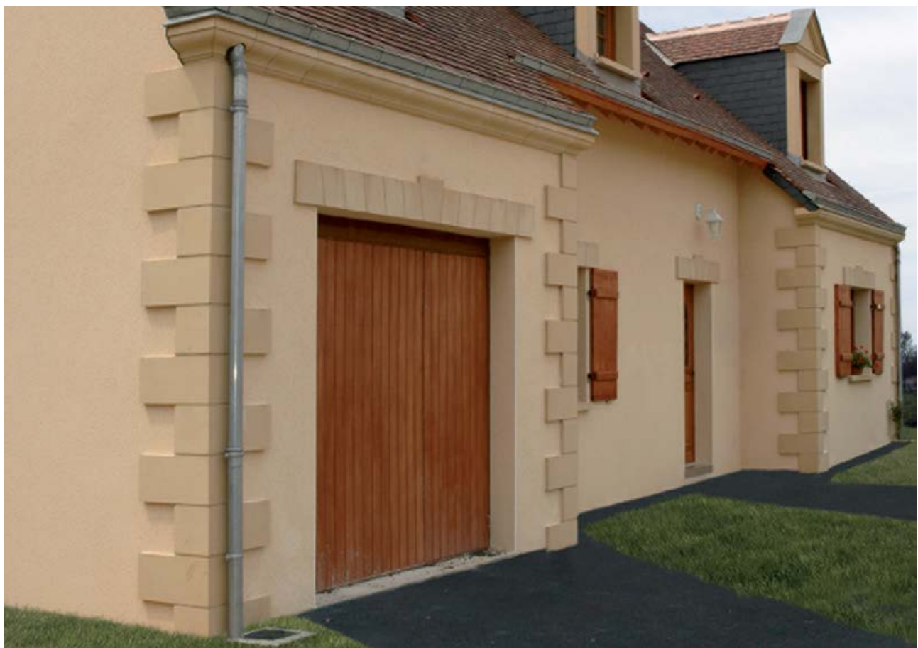
Encadrements de portes et fenêtres – Ton Pierre
