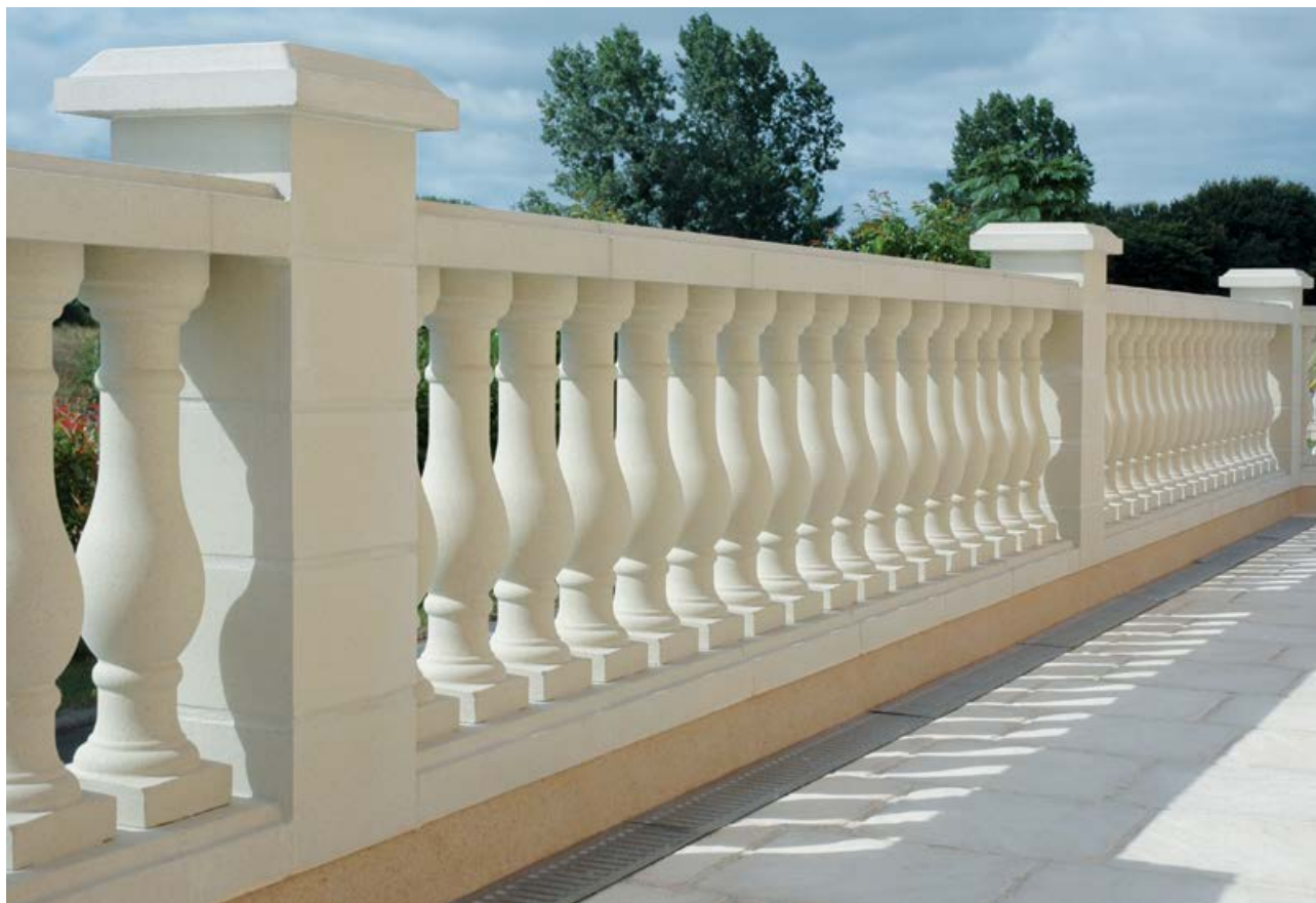
Balustres Pornic 59 et Trumeaux Blanc Cassé – Pose non alignée
