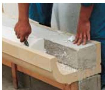
▲ Le modèle CR-CG a été étudié pour pouvoir être superposé sur un modèle CO ou CC formant ainsi une corniche plus volumineuse.
