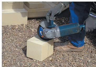
Ajustage des cubes par tronçonnage. Pose du balustre sur limon d'escalier.
