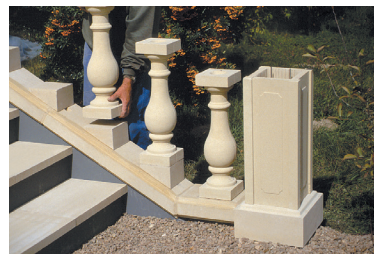
Ajustage des cubes par tronçonnage. Pose du balustre sur limon d'escalier.
