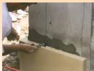
Fixation par vissage de l'agrafe
