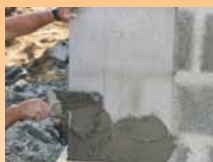
Encollage du mur
